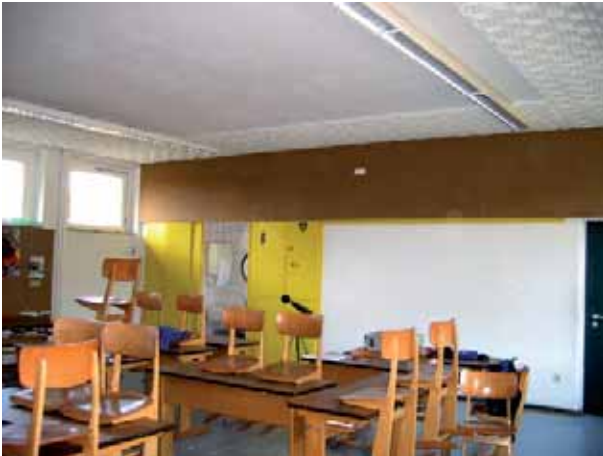
Abb. 32: Raum 24 der Bernhard-Adelung-Schule in Eigenarbeit mit Melaminharzschaumplatten akustisch gestaltet.
