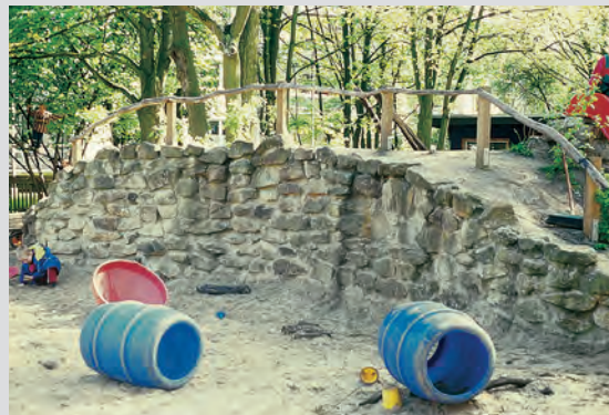
Natursteinwand mit Handlauf als Absturzsicherung
