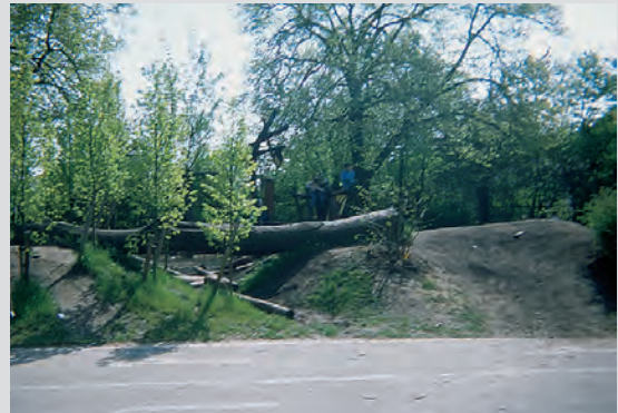
Stoßdämpfender Untergrund unter „Brücke“ mangelhaft (Baumstämme)
