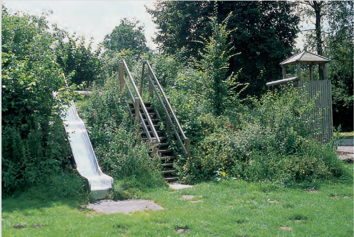
Ausreichend befestigte Rutsche (DIN EN 1176), ungeeigneter Auslaufbereich
