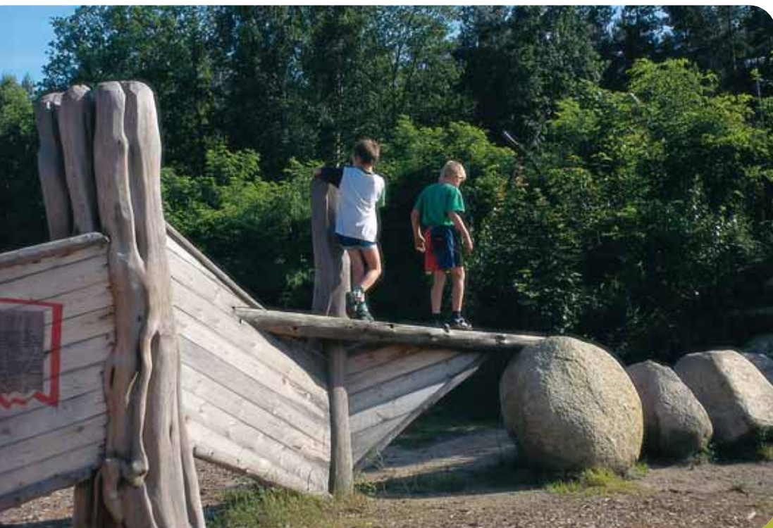
Balancieren in einer Höhe von 0,6 bis 1,5 m erfordert Rasen als Untergrund
