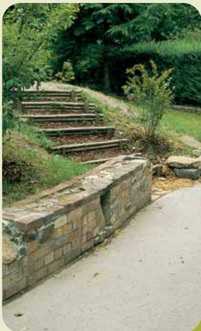
Geeigneter Aufstieg durch Holzbohlen und Rindenmulch, jedoch scharfkantige Mauerbereiche
