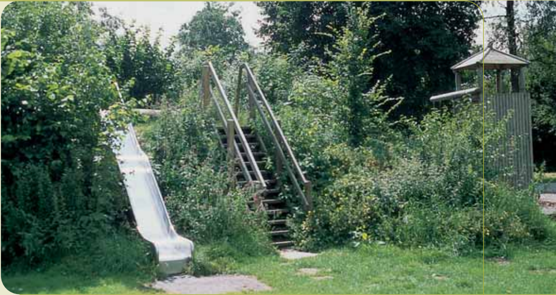
Ausreichend befestigte Rutsche (DIN 7926/EN 1176), ungeeigneter Auslaufbereich
